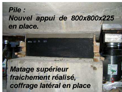
Pile : Nouvel appui en charge
