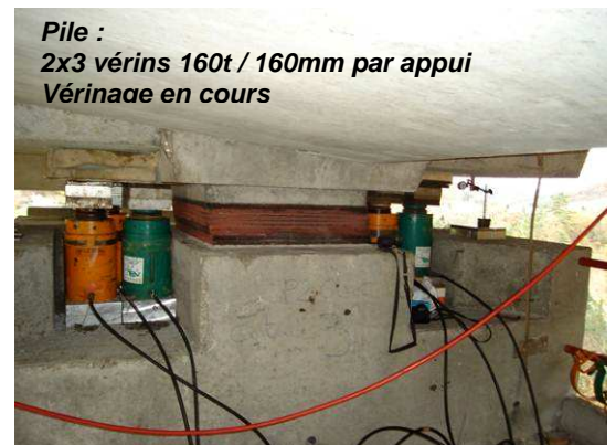
Pile : Nouvel appui de 800x800x225 en place.
