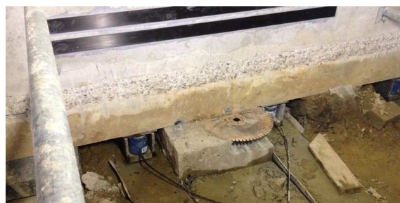
Vérins sous la façade avant (file1).
