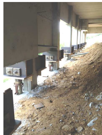
Vérins sous les consoles bridées contre les poteaux - Atelier de pompage et exemple de coffrage de consoles
