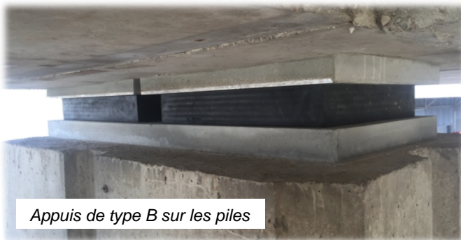
Tablier en appuis sur les vérins, bossages démolis
